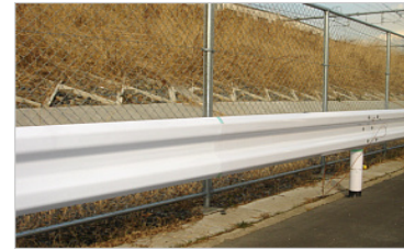
ガードレール
